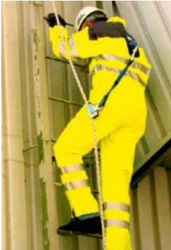
Bild 2: Beispiel des Auffangsystems mit einem mitlaufenden Auffanggerät einschließlich beweglicher Führung
