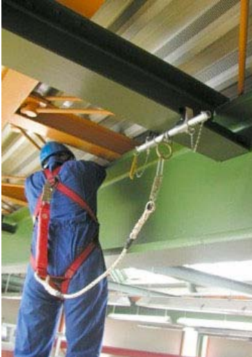
Bild 8: Beispiel eines Auffangsystems mit Falldämpfer
